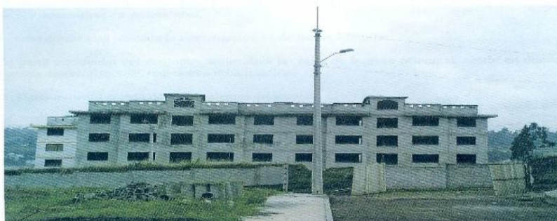
VISTA FRONTAL DE LOS BLOQUES No.3 y No.4
